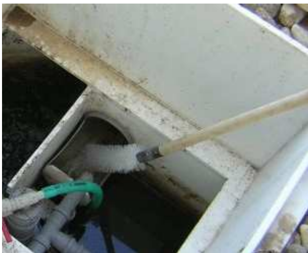
čištění odtokového žlabu
