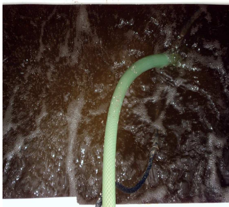
hladina v aktivačním prostoru při správné funkci provzdušňování
